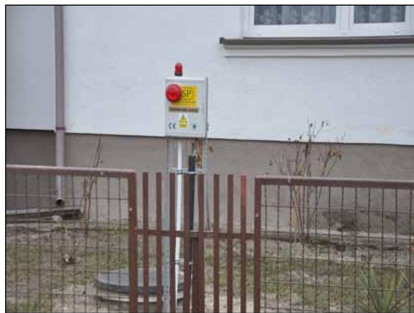
Przepompownia przydomowa
